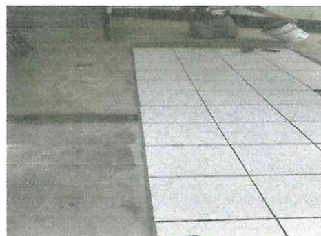
Foto 6: sustitucion de plancha de cemento por piso ceramico
