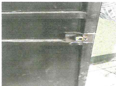
Foto 3: Cambio de chapa en cocina
