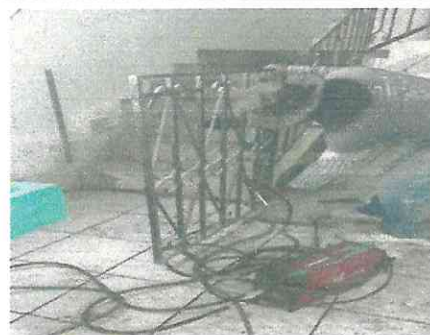
Foto 4: Instalar puerta de gradas
