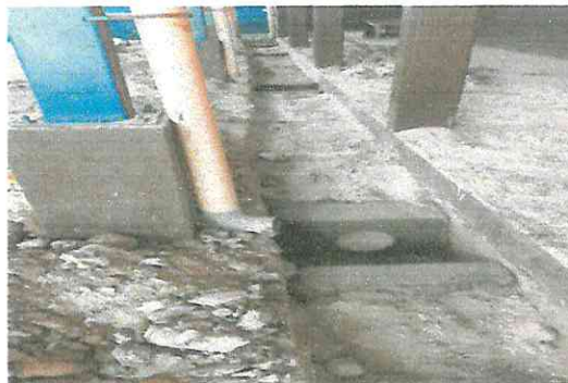
Foto 2: Unificacion de tuberia de agua pluvial en cancha
